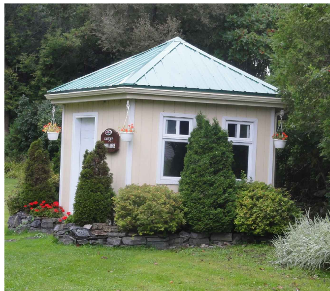
6- BÂTIMENT DE SERVICES
