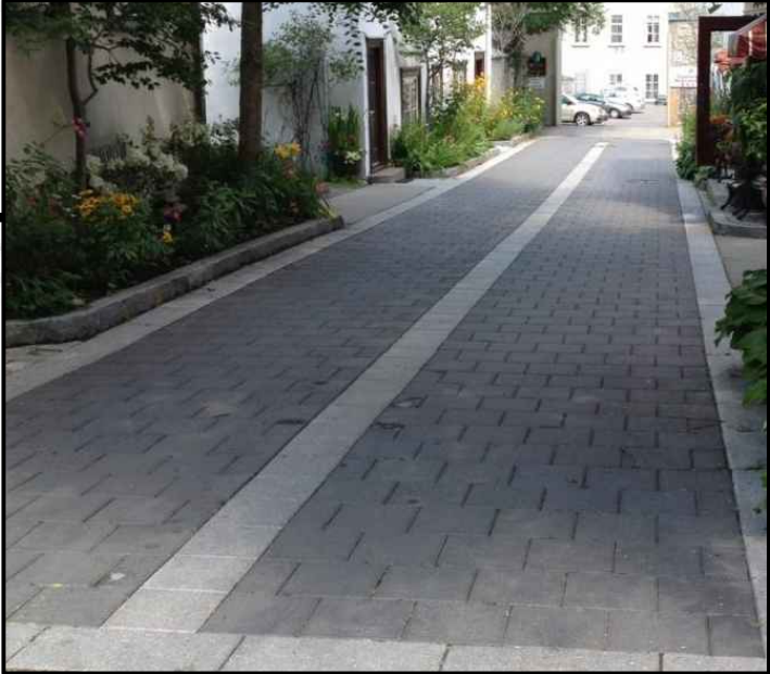
RUELLE RÉAMÉNAGÉE AVEC PAVÉ DE BÉTON ET PLANTATIONS
