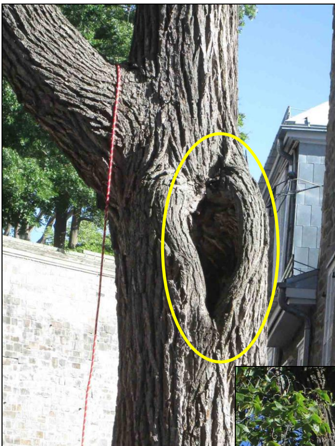
Photo 9 : Cavité suite à la coupe passée d'une branche principale à environ 3,5 m du sol
